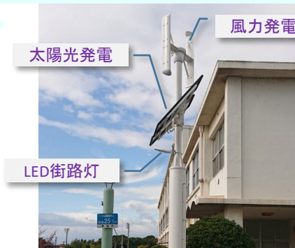
太陽光風力発電式街路灯 （避難施設等の敷地内）
